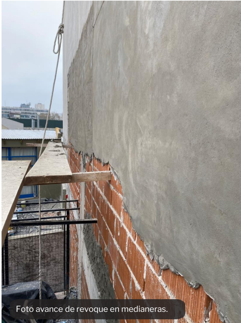
Foto avance de revoque en medianeras.
